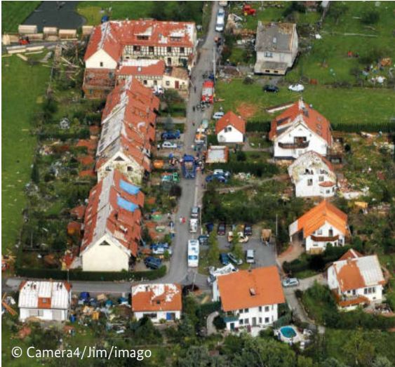
Von einem Tornado zerstörtes Wohngebiet in Quirla, Thüringen, 2006
